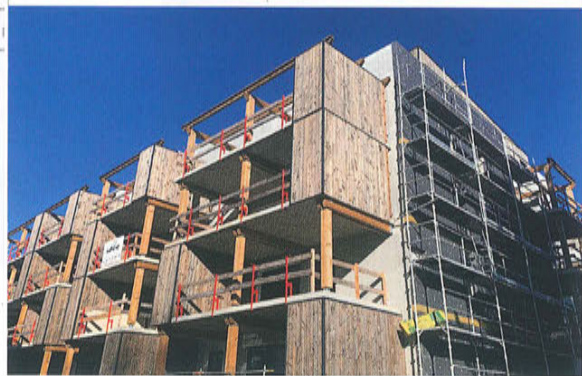
Chantier de la première opération d'Habitée, à Bassens (73).
