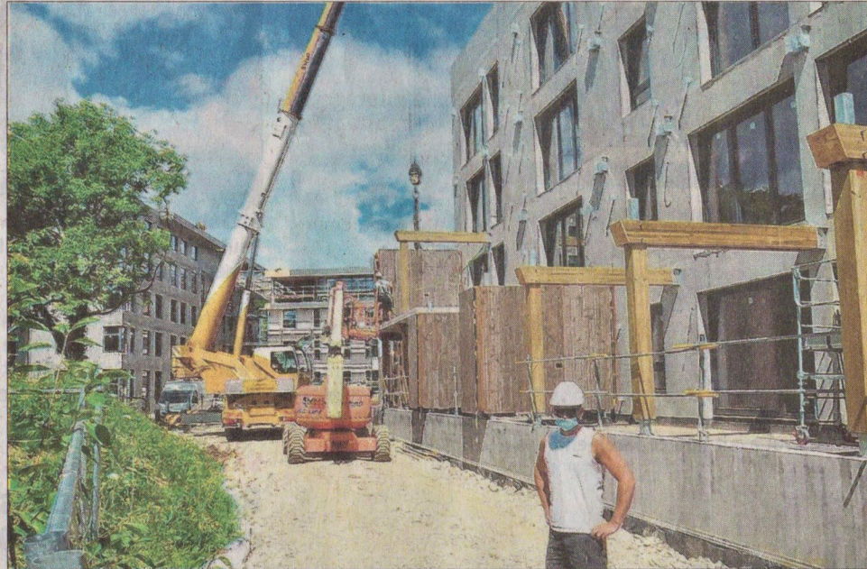
La société SDCC entreprend cette pose des balcons durant deux semaines. Photo Le DL/P.H.
